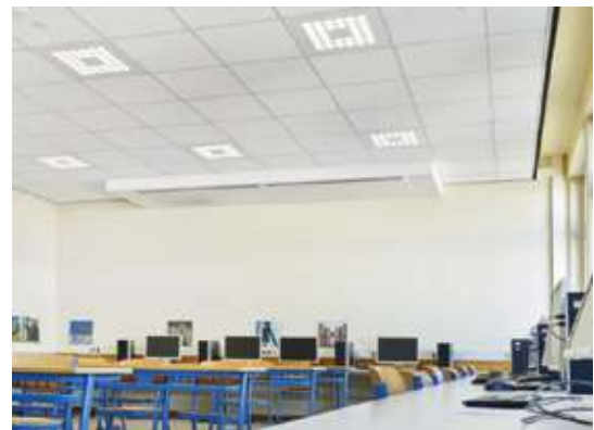
Abb. 4.15: Informatikraum einer Gesamtschule mit bereits abgehängter Decke vor Sanierung (links). Teilintegration des Deckenlüftungsgeräts in vorhandene unsymmetrische Systemdecke mit Aussparung vor der Fensterwand sowie Austausch der Absorberplatten und Wechsel von Anbauleuchten (Leuchtstoffröhren) gegen Einlegeleuchten (LED) (rechts).
