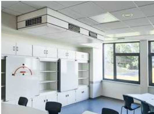
Abb. 3.10: 1/3-Teilintegration eines Deckenlüftungsgeräts (© Airflow Lufttechnik GmbH) in Systemdecke mit abgekoffter Rohrführung durch Fensterwand (Rachel-Carson-Schule, Dormagen) [2].
