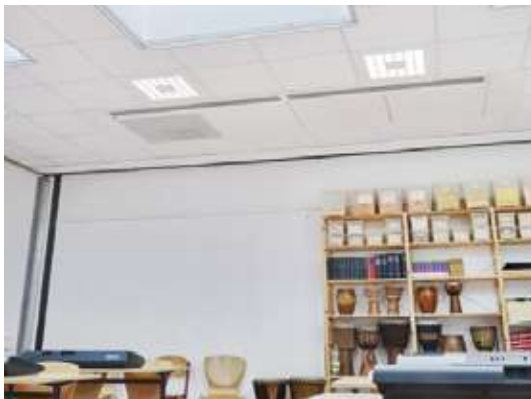
Abb. 3.8: Flächig vollintegriertes Deckenlüftungsgerät (TROX GmbH) mit unsichtbarer Rohrführung durch die Decke in einem Musikraum (Fall W-G0V, Seite 85).
