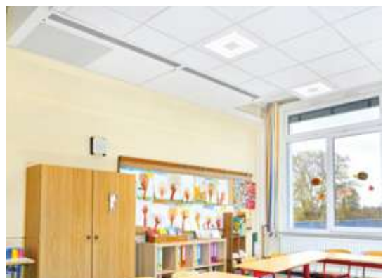
Abb. 4.25: Deckenlüftungsgerät an der Klassenraumrückseite mit teilflächig abgehängter Systemdecke. Variante Akustikdeckenstreifen (3,6 m) mit Anbauleuchten (links) und Variante Akustikdeckenstreifen (4,4 m) und Einlegeleuchten (rechts).
