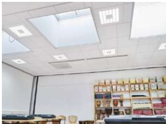
Abb. 4.13: Innenliegender Musikraum eines Gymnasiums mit Lichtkuppeln ohne Außenwände und Fenster vor der Sanierung (links). Vollintegration des Deckenlüftungsgeräts in eine vorhandene Systemdecke mit Austausch der Einlegeleuchten (rechts). Der Luftreiniger wurde zwischenzeitlich an einer anderen Position aufgestellt.
