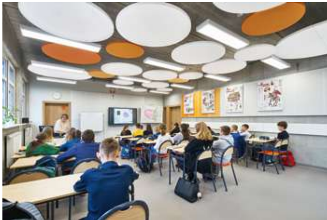
Abb. 2.14: Lokal installierte Deckensegel (Primary School no 46 in Poznan) zur Reduktion der Nachhallzeit (ROCKWOOL Rockfon GmbH [69]).
