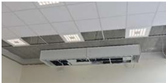
Abb. 4.16: Lokaler Rückbau einer vorhandenen Systemdecke (oben) und Installation eines Deckenlüftungsgeräts in eine Zarge (unten).
