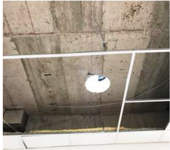
Abb. 4.7: Kernbohrung durch die freigelegte Rohdecke zur Kanaldurchführung.
