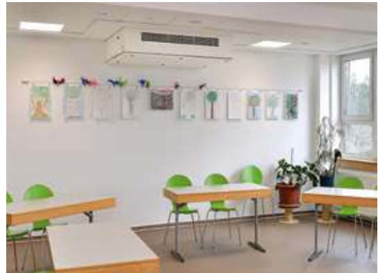
Abb. 3.11: Teilintegriertes Deckenlüftungsgerät (tecator GmbH) in Systemdecke an Raumrückseite mit unsichtbarer Rohrführung durch angrenzende Wand (TSA Bildung und Soziales gGmbH, Jena).
