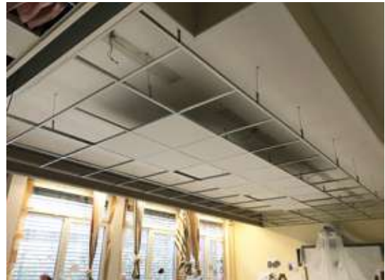
Abb. 4.24: Installation der Anbauleuchten mit rückseitiger Verstärkung durch OSB-Platten zum Abfangen der Last und seitlicher Abkofferung des Systemdeckenstreifens (links) und Vorbereitung der Systemdecke mit Revisionsaussparung für das Deckenlüftungsgerät vor Einlegen der restlichen Mineralfaserplatten und LED-Deckenleuchten (rechts).
