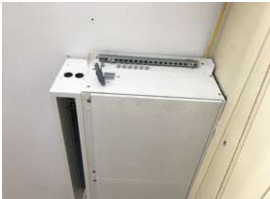
Abb. 4.20: Durch die in diesem Fall seitlich positionierten Anschlüsse erfolgten der elektrische Anschluss sowie die Einbindung in den Heizkreis.
