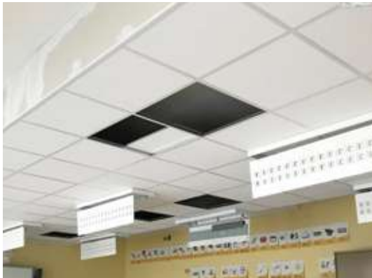
Abb. 4.24: Installation der Anbauleuchten mit rückseitiger Verstärkung durch OSB-Platten zum Abfangen der Last und seitlicher Abkofferung des Systemdeckenstreifens (links) und Vorbereitung der Systemdecke mit Revisionsaussparung für das Deckenlüftungsgerät vor Einlegen der restlichen Mineralfaserplatten und LED-Deckenleuchten (rechts).
