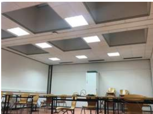
Abb. 4.13: Innenliegender Musikraum eines Gymnasiums mit Lichtkuppeln ohne Außenwände und Fenster vor der Sanierung (links). Vollintegration des Deckenlüftungsgeräts in eine vorhandene Systemdecke mit Austausch der Einlegeleuchten (rechts). Der Luftreiniger wurde zwischenzeitlich an einer anderen Position aufgestellt.
