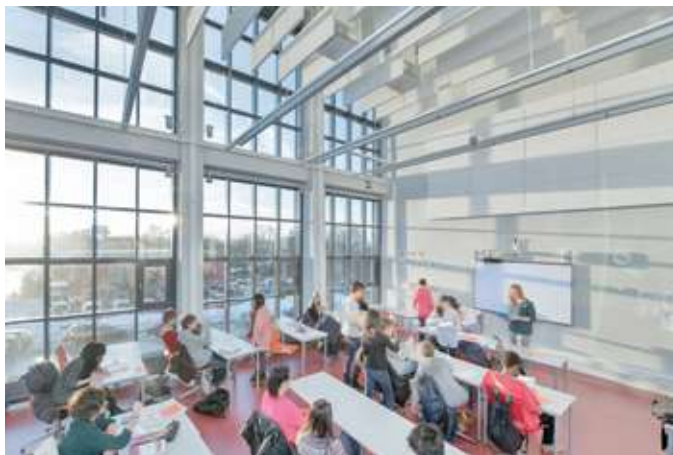
Abb. 2.15: Vertikal von der Decke abgehängte Baffeln zur Reduktion der Nachhallzeit (ROCKWOOL Rockfon GmbH).
