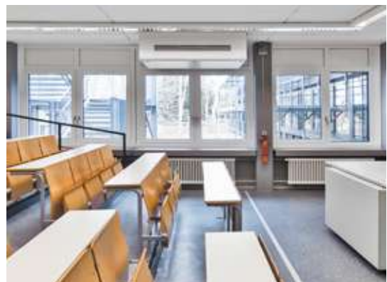
Abb. 3.13: Aufgesetztes Deckenlüftungsgerät (tecator GmbH) direkt an der Fensterwand mit Rohrführung durch Oberlicht-Bereich (Einhard-Gymnasium, Aachen) [89].
